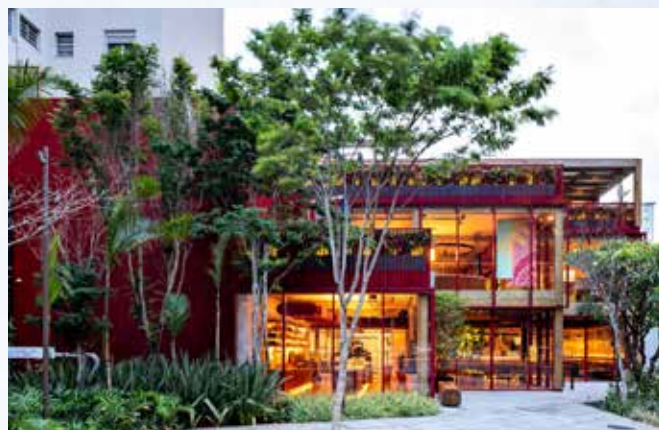
Edifício multipiso construído com o sistema cross-laminated timber – Av Brig Faria Lima – São Paulo – SP
